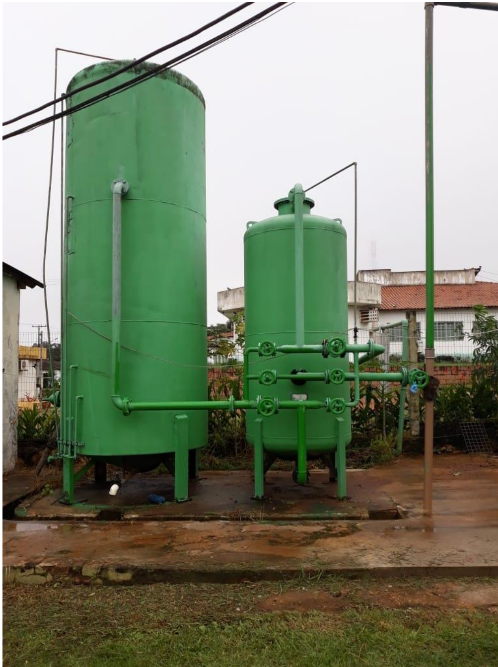
Figura 3- Sistema de tratamento existente, filtros
